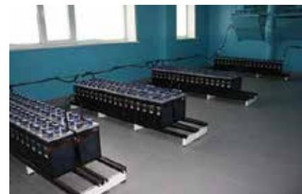
Рис. 5. Расположение СКАБ в аккумуляторном помещении
