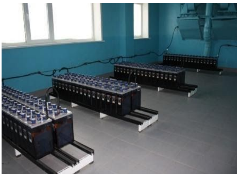
Рисунок 2.4 – Аккумуляторное помещение
